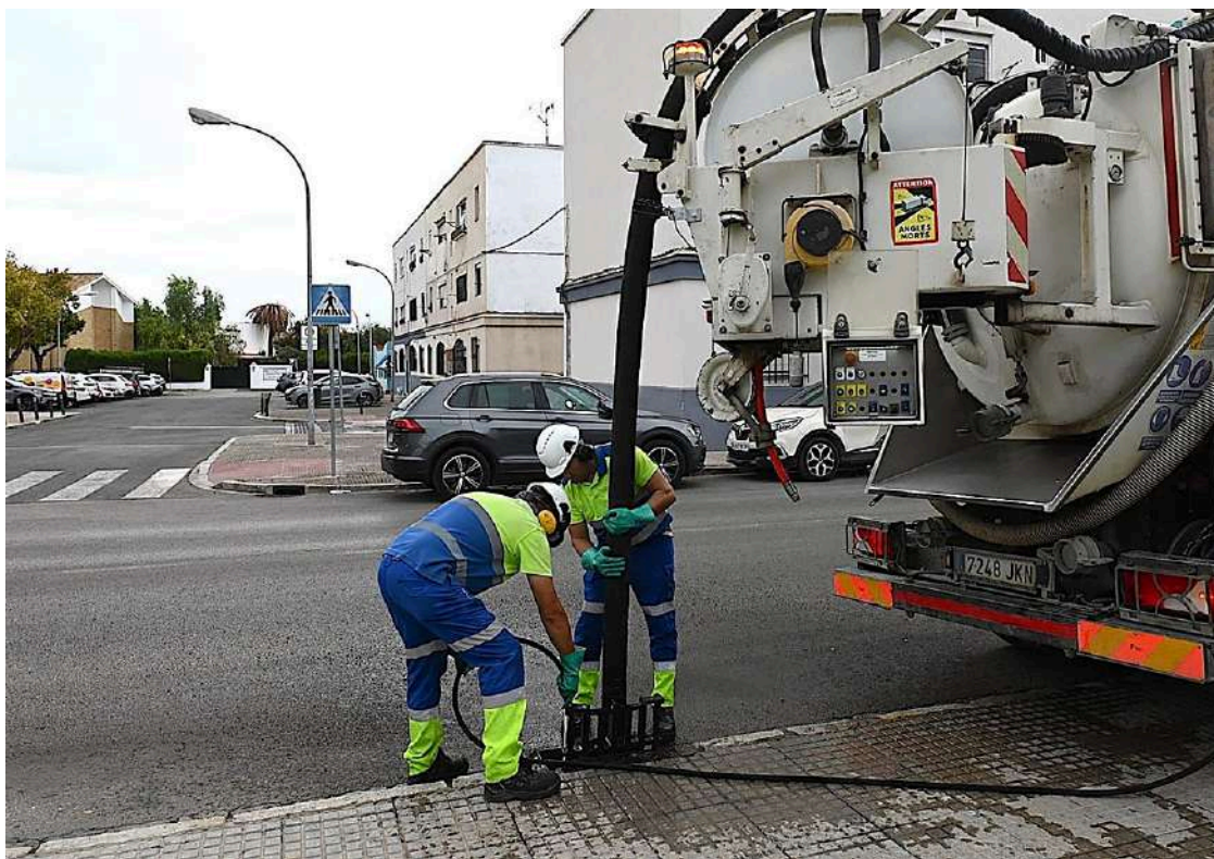
Limpieza de las redes de saneamiento en Jerez de la Frontera. (Ayuntamiento de Jerez)
