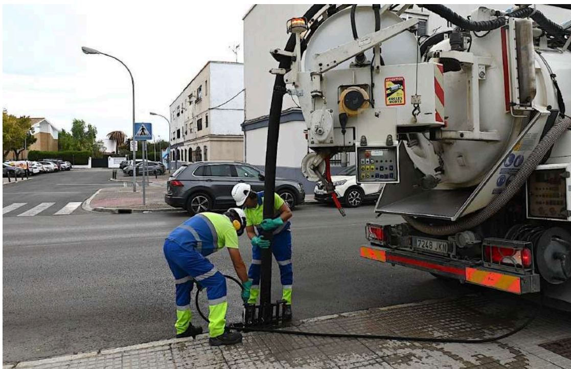
Dos operarios de Aquajerez limpiando un imbornal en la barriada de La Asunción
