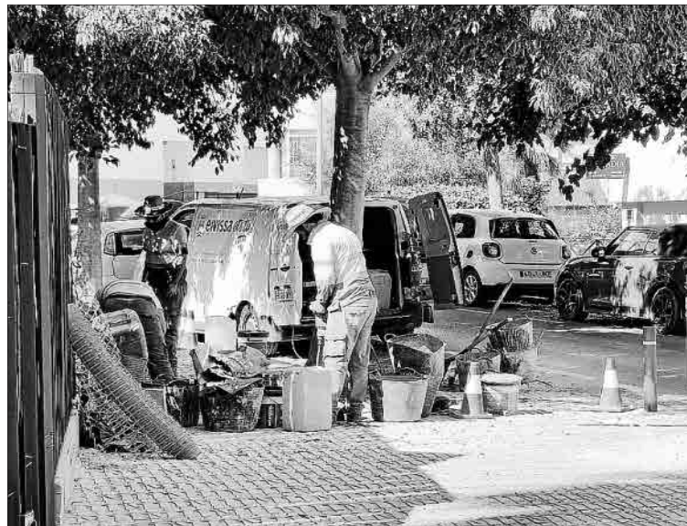
Operarios trabajando para arreglar la avería. Foto: PIF
